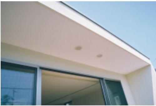
バルコニーのひさし
